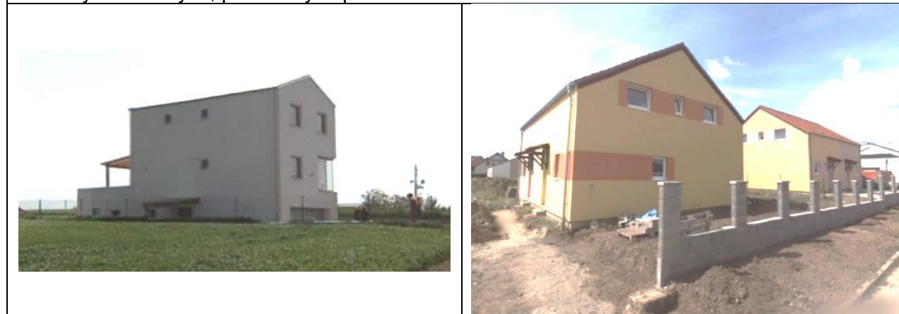
Příklady nevhodných, příliš malých přesahů střešních rovin:
